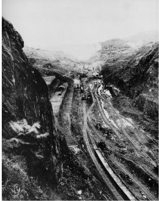
Corte de La Culebra durante la era Stevens. (Fotografía facilitada por el autor).
