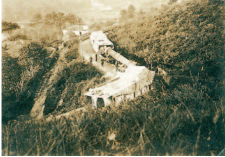
Transporte de piezas de 381/45 mm por vía férrea desmontable y esquema del montaje.
