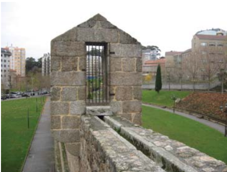
Acueducto. Detalle de la canaleta. Foto de Sasa64 (FLIRK).
